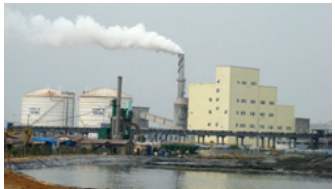
Ảnh 9: Nhà máy phân bón DAP, KCN Bình Vũ, quận Hải An, Hải Phòng
