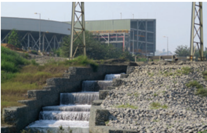
Ảnh 12: Nước thải của công ty Núi Pháo
