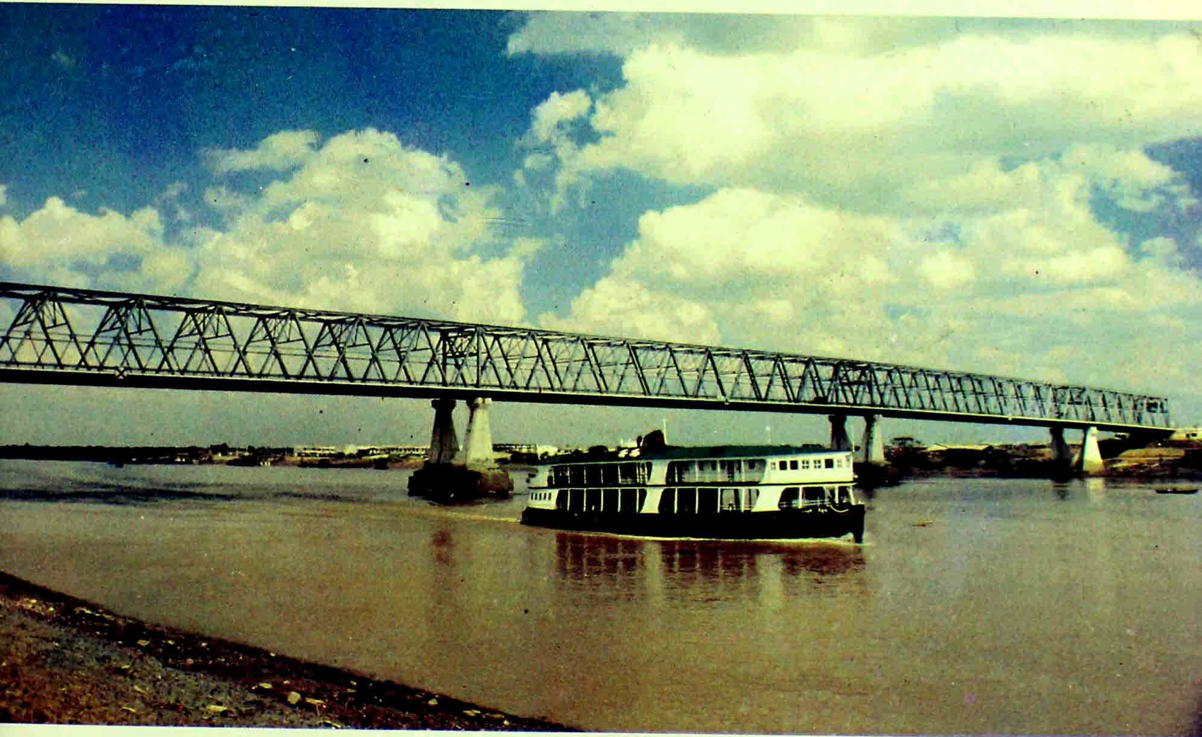
နိုင်ငံတော် ငြိမ်ဝပ်ပိပြားမှု တည်ဆောက်ရေးအဖွဲ့ အစိုးရလက်ထက် တည်ဆောက်ခဲ့သော တံတားကြီးများအနက် တစ်ခုဖြစ်သော ဘုရင့်နောင်တံတား
