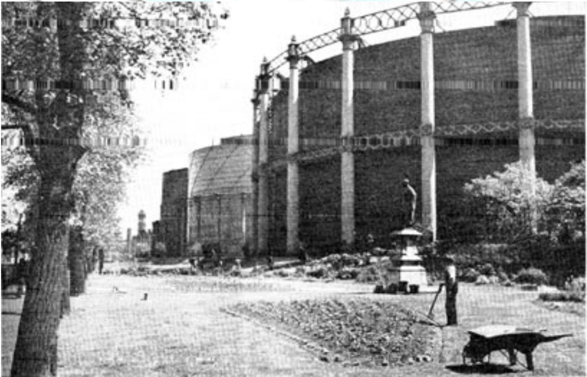
ဓာတ်ငွေ့ချက်ပြီးနောက် ဤသို့လှောင်ကန်ကြီးများတွင် ထားရှိရသည်
